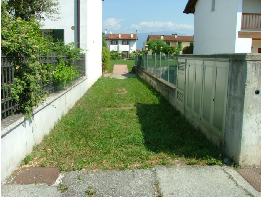
Area pedonale Quartiere Montegrappa (Foto n. 1)
